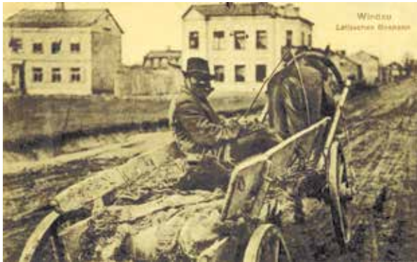
Skats uz Bērzu ielu no Sarkanā tilta puses. 20. gs. sākums.
