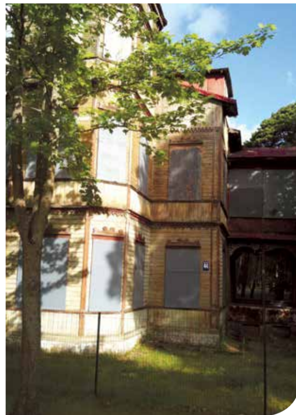
“Ventpils.lv” novēroja, ka ap ēku Vasarnīcu ielā 44 apvilks metāla žogs, un tādā pilsētnieku drošību tā neapdraud. Līdz ar to var secināt, ka taisnība drīzāk būs Ventpils pilsētas domes Būvniecības administratīvās inspekcijas teiktajam...
