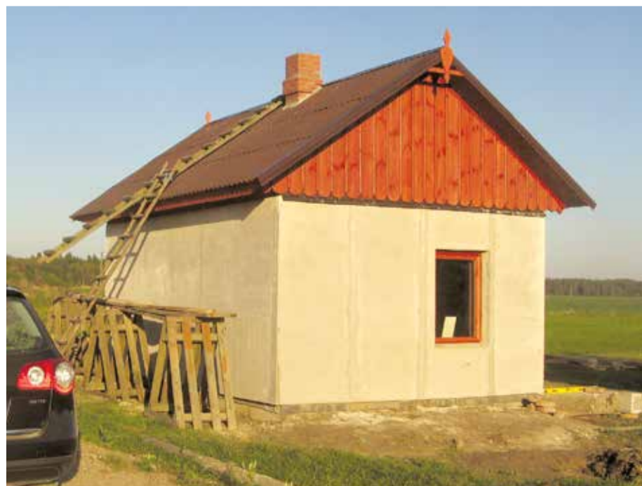
Осталось выполнить внутренние отделочные работы, и можно будет обживать здание, построенное из самодельных кирпичей.
