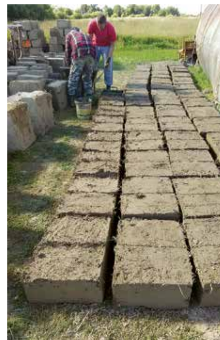
В процессе: в траве сушится будущая стена здания.
