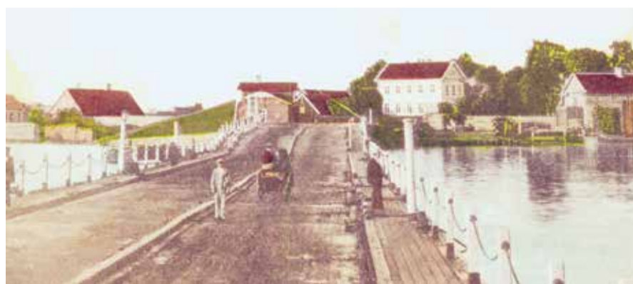
Plosta ielas sākums, skatoties no tilta puses.
