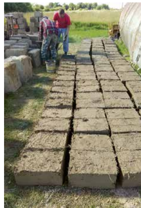
Process: zālē žūšanai izklāta ēkas nākamā siena.
