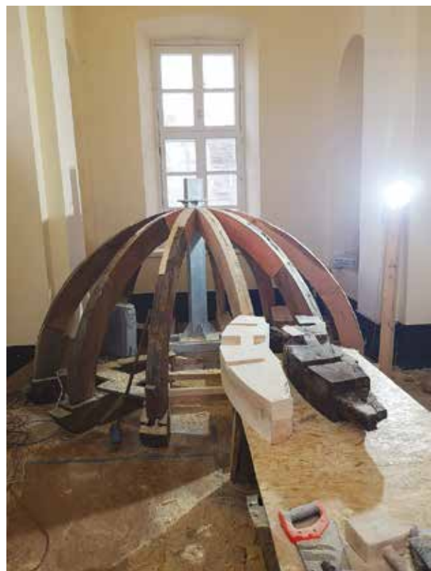
Замененные участки элементов деревянных конструкций выглядят точно так же, как работа старых мастеров.
