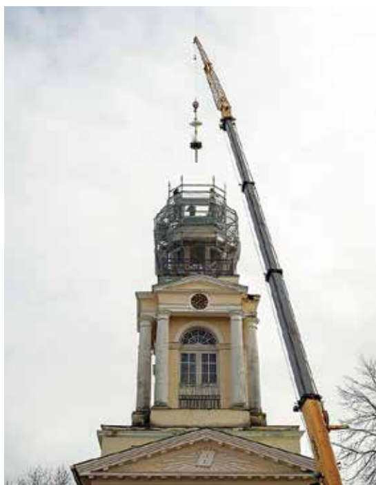
Поднятие восстановленного креста на восстановленную башню церкви.
