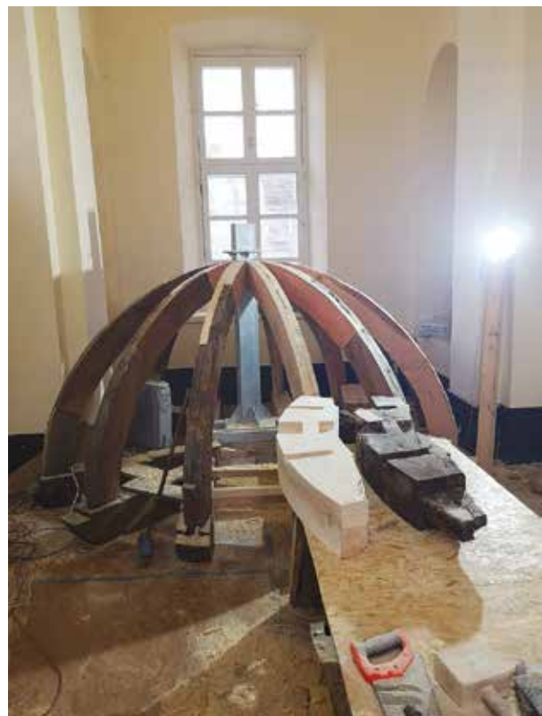
Nomainītie koka konstrukciju elementu posmi izskatās tieši tāpat kā seno meistar darbs.
